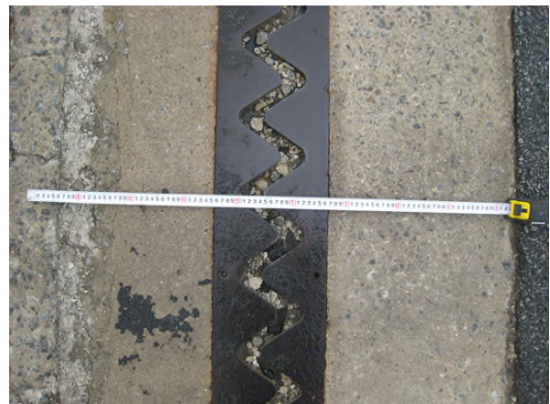
신축이음 이동량 측정
