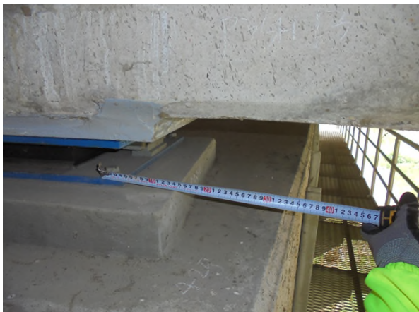
받침장치 연단거리 측정
